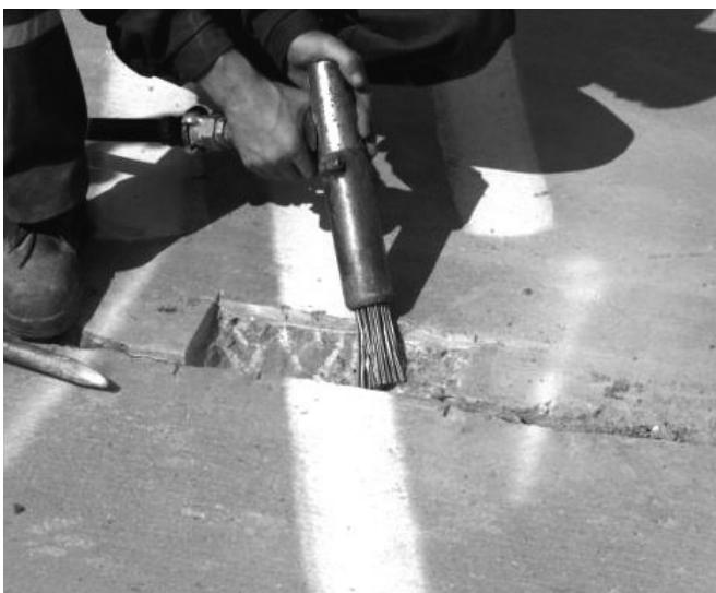
*Рис. 14. Подготовка бетона игольчатым пистолетом*
