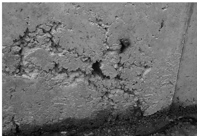
*Рис. 4. Непровибрированные участки стены*
