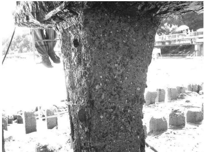
Рис. 19. Бетонная опора, подготовленная к ремонту
