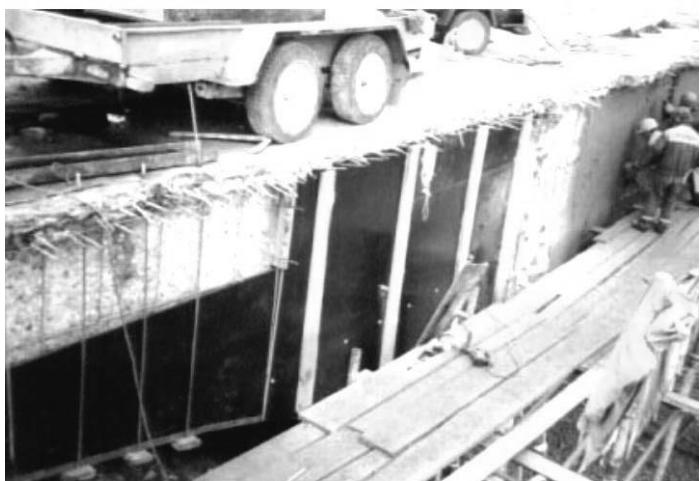
*Рис. 25. Нанесение ремонтного состава методом набрызга:
