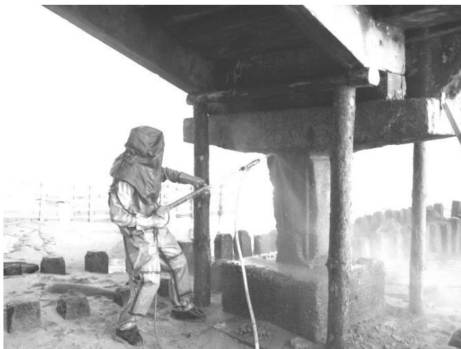
*Рис. 21. Очистка поверхности бетона помошью водопескоструйной установки*
