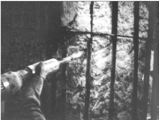
*Рис. 13. Подготовка поверхности с помощью бучарды*
