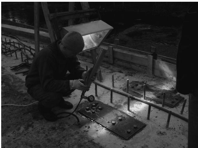
*Рис. 38. Инъецирование трещины ручным насосом*
