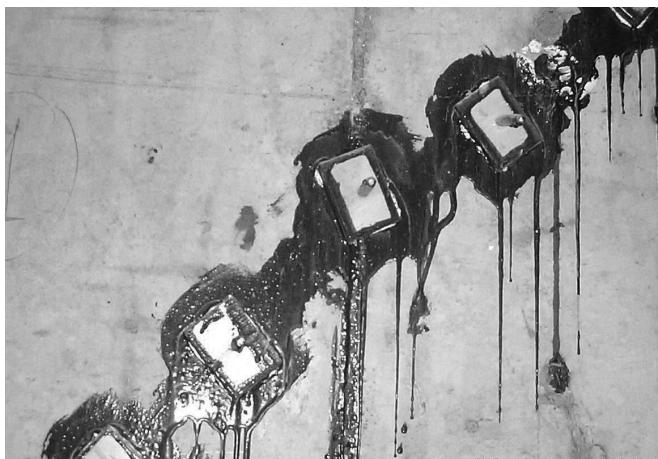
*Рис. 40. Штуцера для низконапорной технологии инъецирования, наклеенные вдоль трещины*
