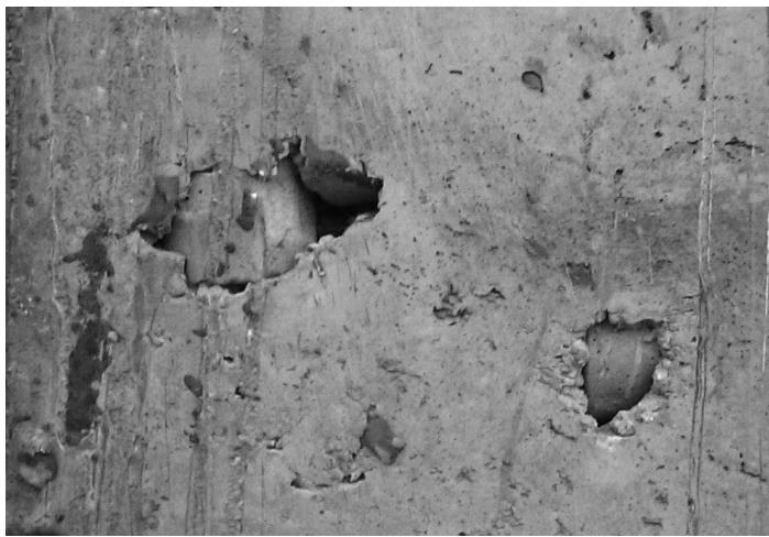
*Рис. 5. Зависание бетонной смеси в зоне «сухарей»*
