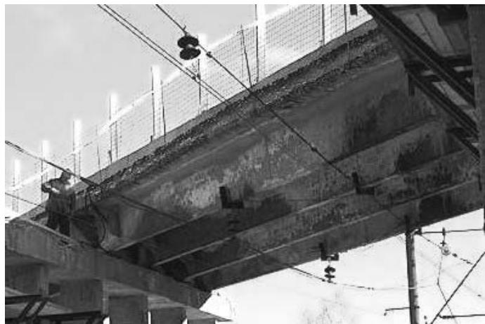
*Рис. 7. Разрушение бетона пролетного строения*
