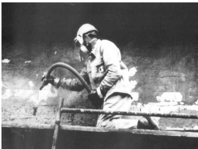
*Рис. 22. Очистка поверхности с помощью пескоструйной установки*
