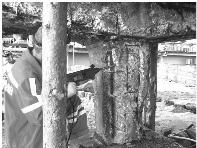
Рис. 20. Подготовка бетонной поверхности опоры с помощью перфоратора
