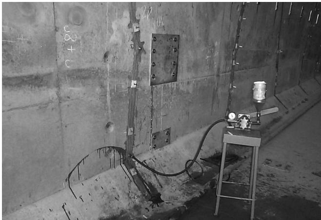
*Рис. 39. Инъецирование трещин по высоконапорной технологии*
