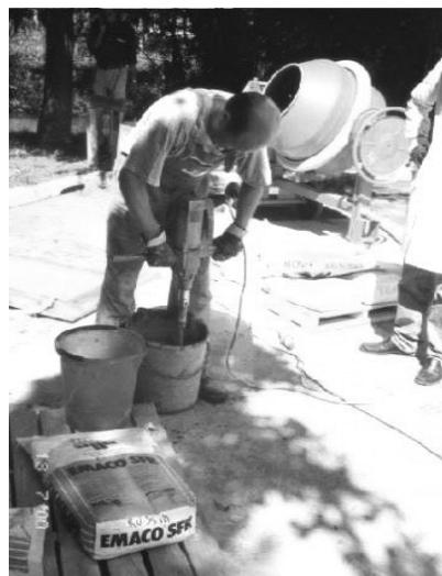
*Рис. 12. Приготовление ремонтных смесей EMACO® на различном оборудовании: а) в бетономешалке; б) с помощью дрели с насадкой*
