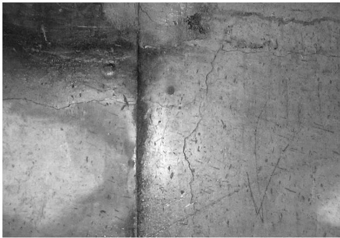
*Рис. 6. Усадочные трещины на поверхности стены автодорожного тоннеля*
